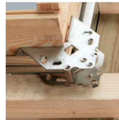
Präzise Montage von Dachwohnfenster und Dämmrahmen durch aufeinander abgestimmte Montagewinkel.
