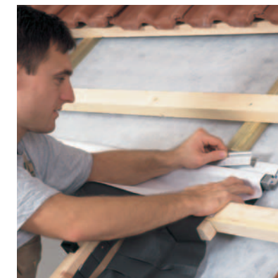
Montage der Wasserableitrinne.
